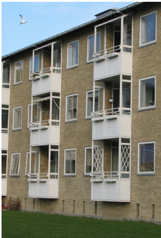
14 boliger i seniorbofællesskabet Druehaven, der er indrettet i to opgange i FB's afdeling Folehaven, Druehaven 39-41, 2500 Valby
